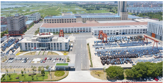
屋顶光伏设备
