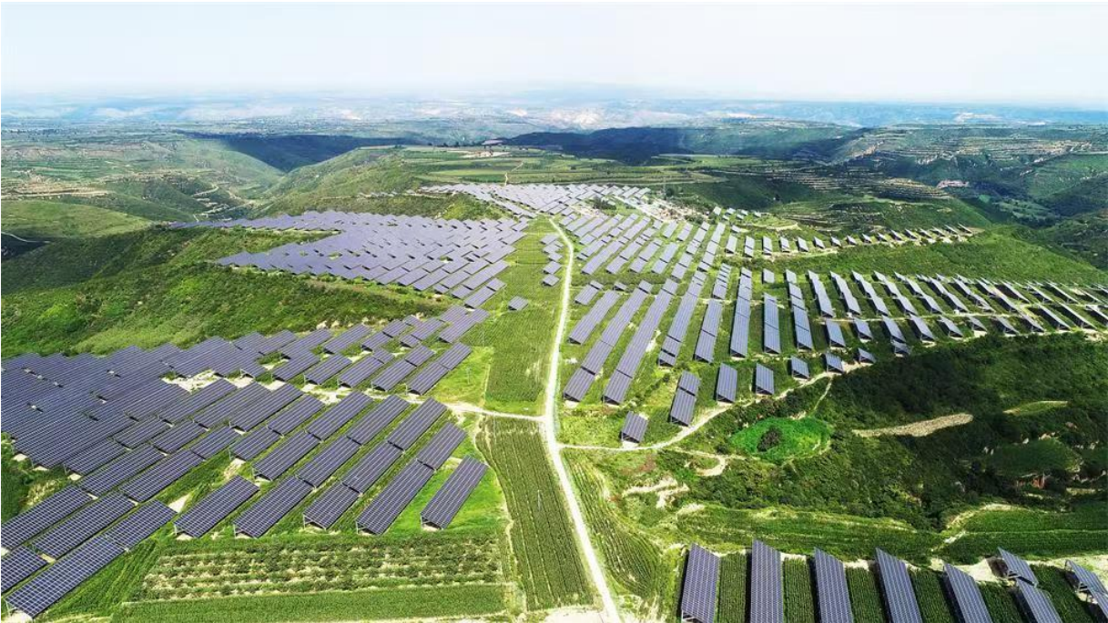
新疆尼勒克光伏发电项目
