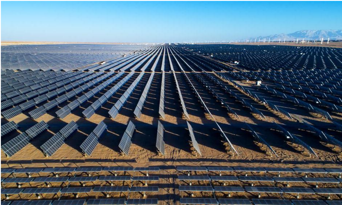
青海格尔木多能互补光伏电站
