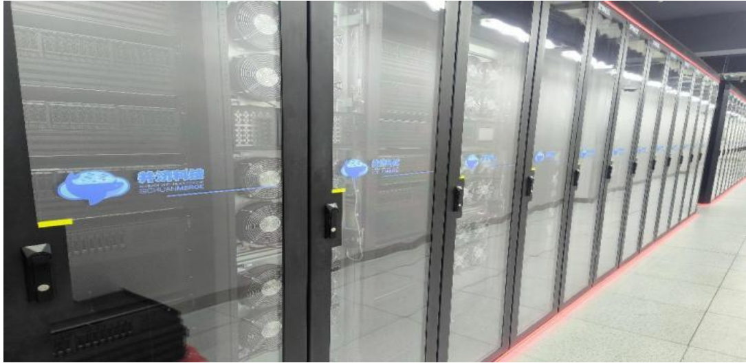
川南智算中心项目
