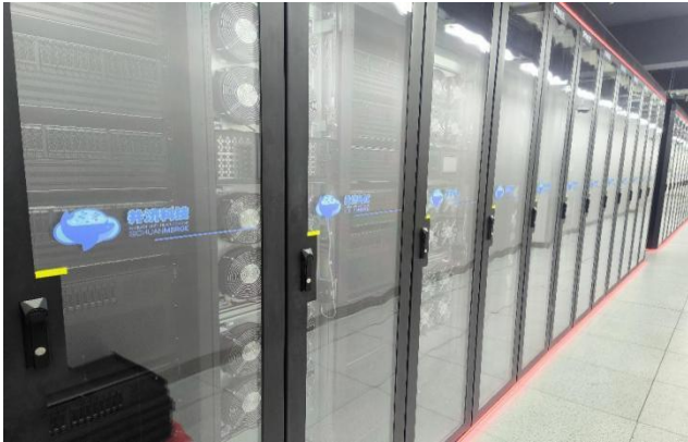
图 16 川南智算中心项目
