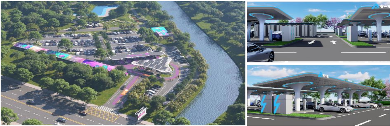
图 13 深圳笔架山公园南门光储充示范站项目
