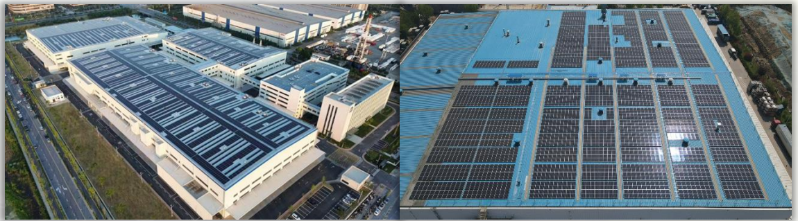
延锋座椅临港飞渡路工厂光伏，装机容量：5兆瓦
