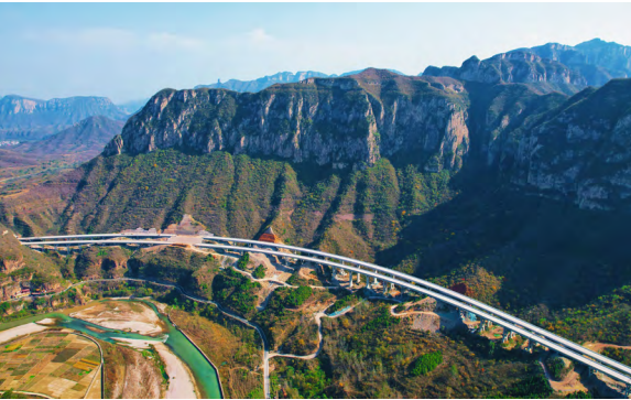
绿地旗下河南公路工程局承建的沿太行高速安阳段
