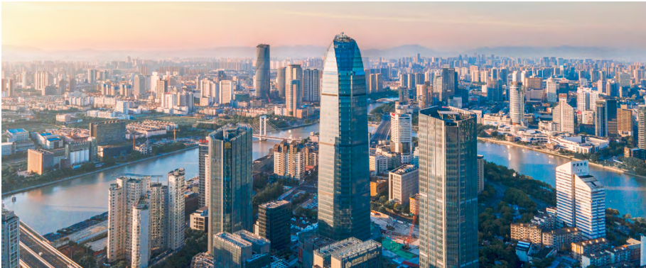
宁波绿地中心在产品调改方面，将沿江写字楼改造为宁波唯一三江口大平层，着力打造 40 层两种户型样板间，同时，更新提升 37 楼空中会馆，完善配套服务。在运营提升方面，引进各具特色的夜间休闲业态。项目已全新对外展示，在品质、服务和体验等方面获得好评。
