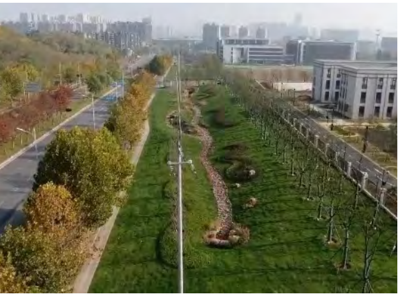
绿地大基建旗下江苏省建所属南京同力建设承建的江北新区法治园区配套道路及环境提升工程在南京市海绵城市建设优秀项目评选活动中获得“优秀项目四星奖”。项目积极践行海绵城市建设理念，布局下凹绿地与透水铺装等设施，以花草种植、天然石铺地与植物组团打造旱溪景观，实现生态与景观的双重效果。
