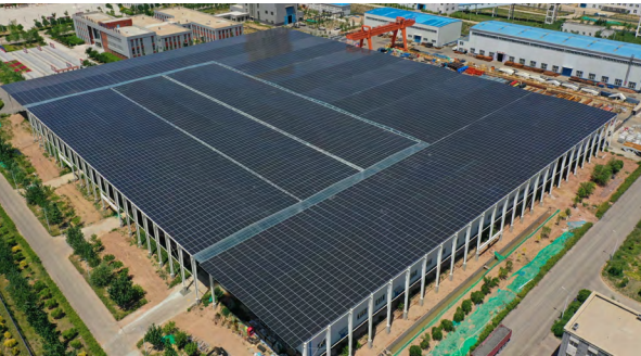
西部能源 6MWp 分布式光伏项目
