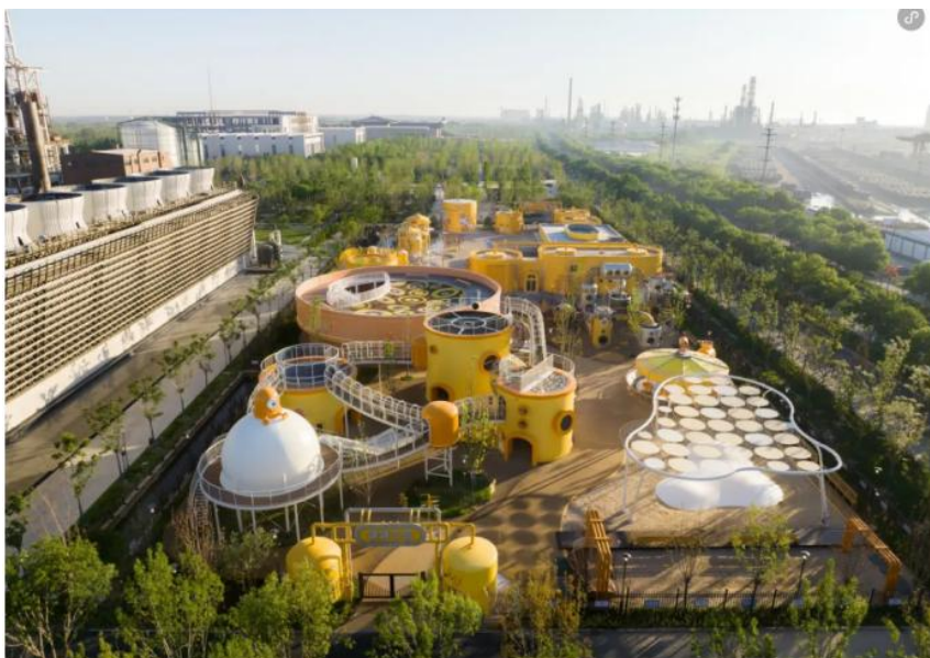
沧州大化工厂遗存提升改造罐罐乐园
