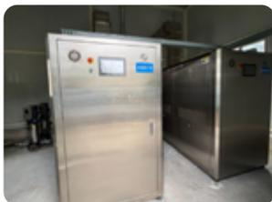
绵阳海立新增两台1T超低氮工业热源机，替代原2T工业燃气锅炉，提高车间热源使用效率，减少氮氧化物排放。
