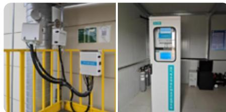
郑州海立新增电泳废气在线监测装置，实时监测废气排放，确保达标排放。
