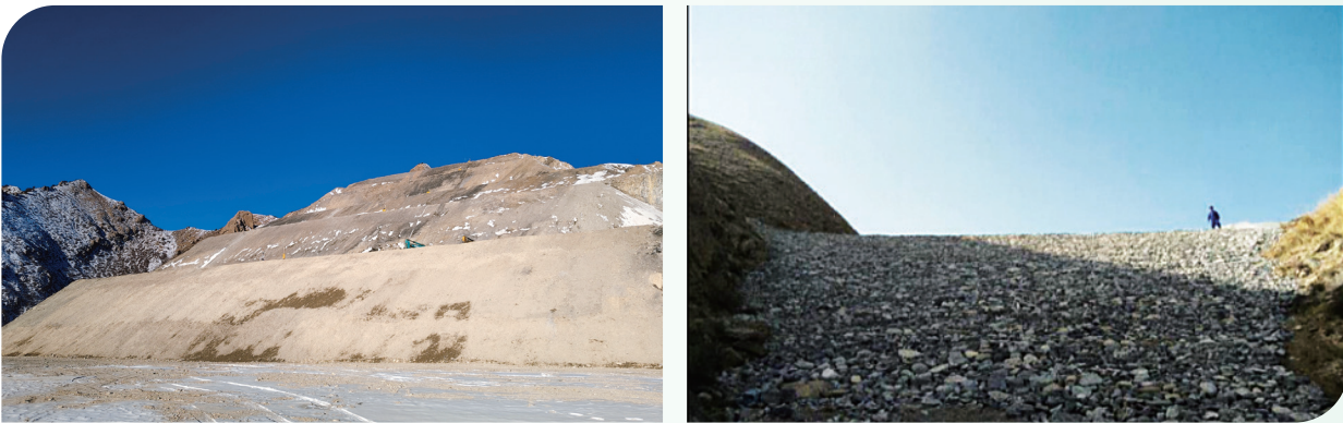
▲ 西沟矿削坡减载
