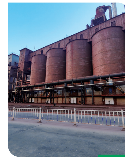
▲ 保温矿仓除尘设施改造后
