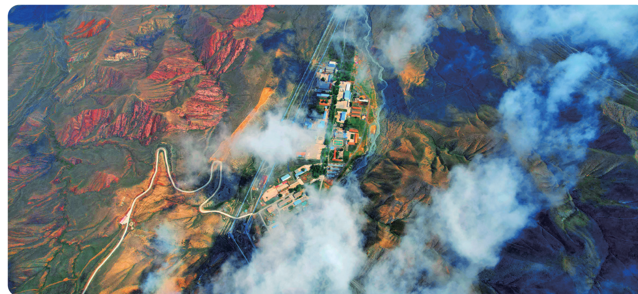
▲西沟矿业公司全景图
