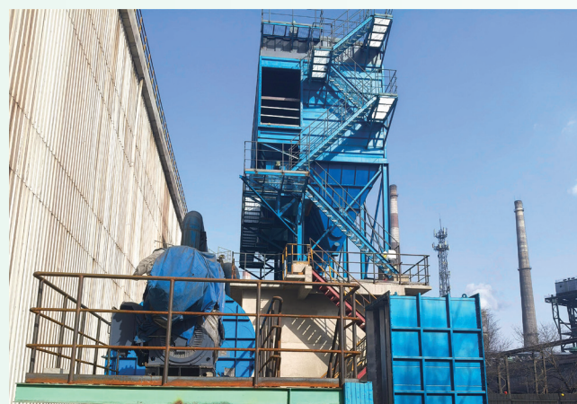
▲ 不锈钢分公司炼钢超低排放改造项目
