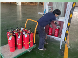
更换消防设备
