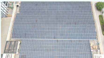
科林南区2号车间光伏项目
