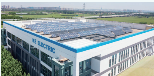
科林南区1号车间光伏项目
