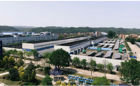
梧州部分光伏项目
