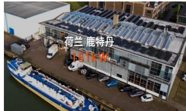
荷兰港口光伏项目
