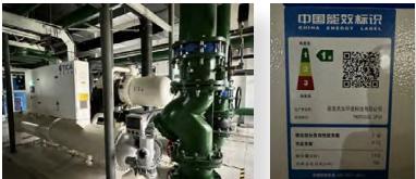
满液式水冷螺杆冷水机组及其能耗标识
