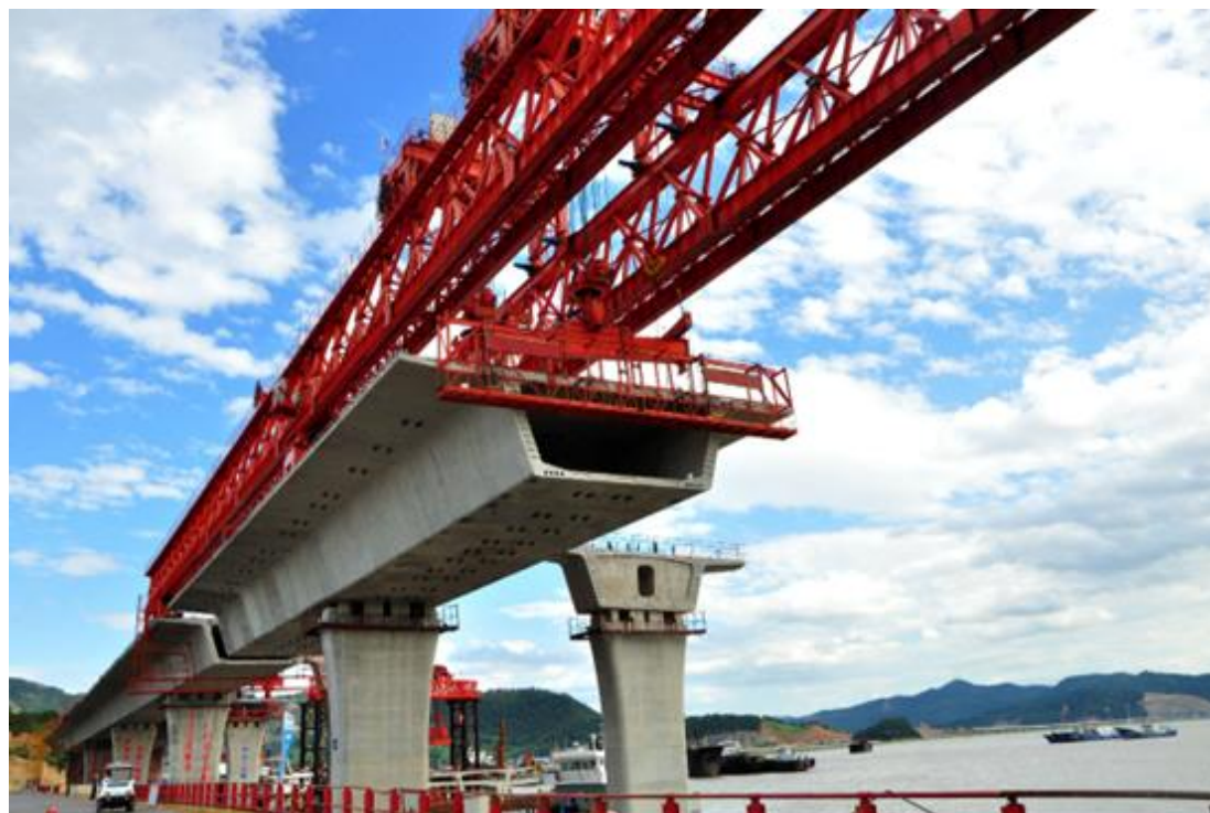
图：节段梁架设实景
