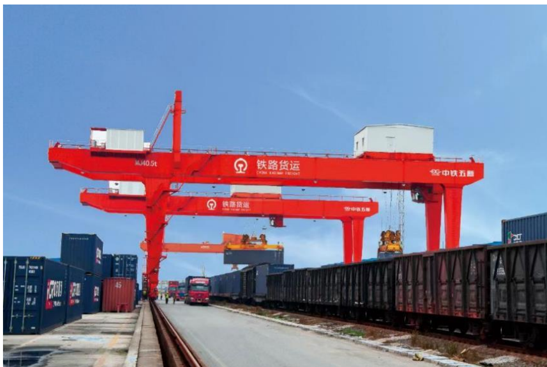
图：铁路货场门式起重机施工实景
