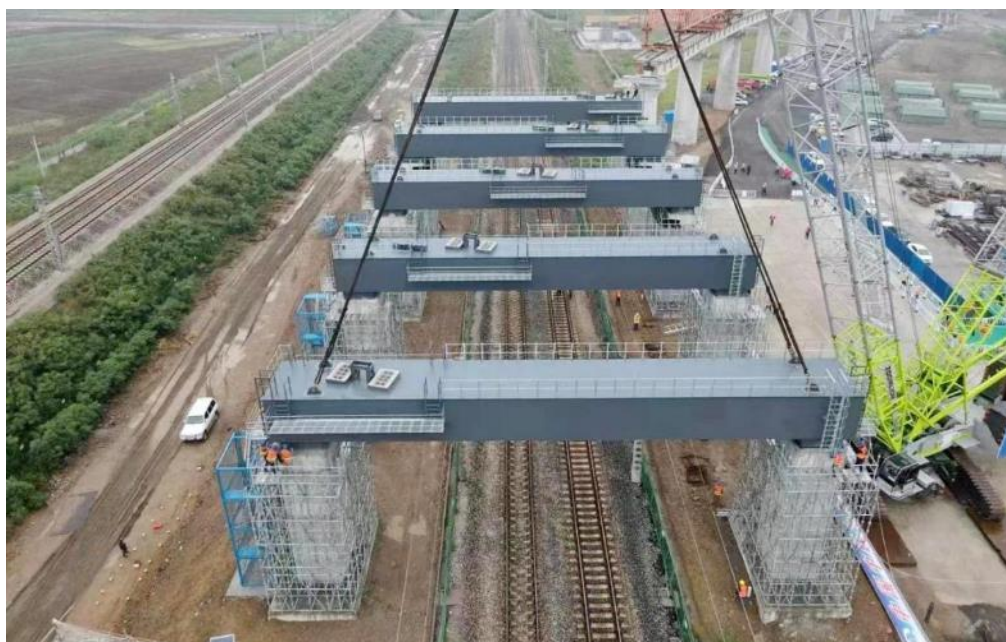
图：门式墩钢梁施工实景
