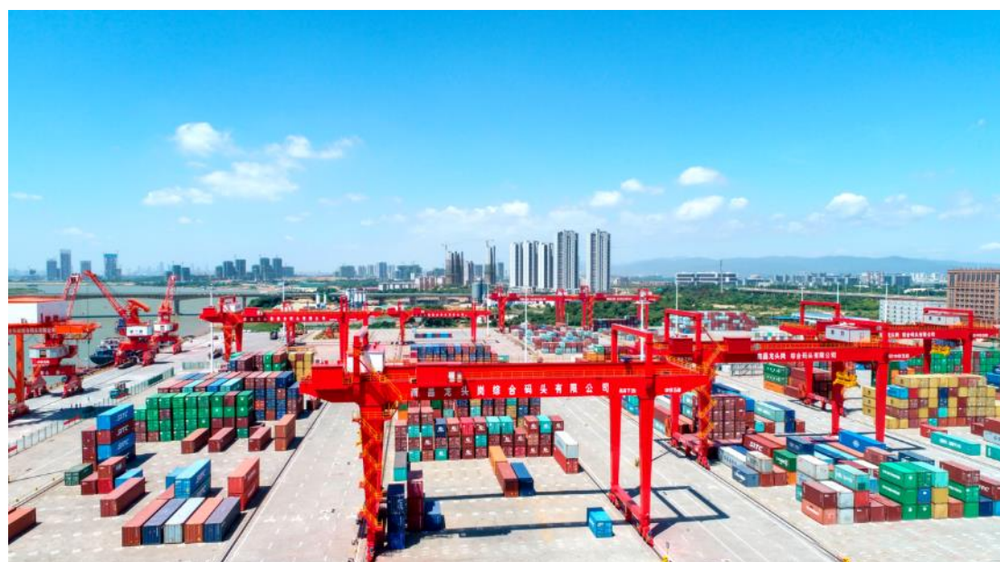
图：轨道式集装箱起重机施工实景
