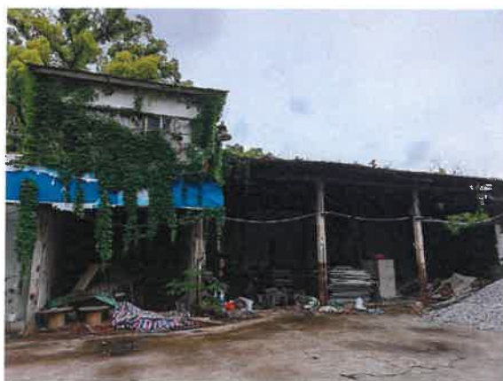
估价对象房屋外观
