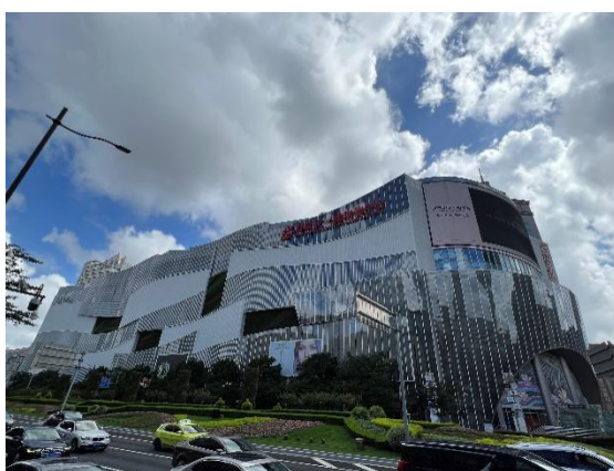
项目外观-西侧
