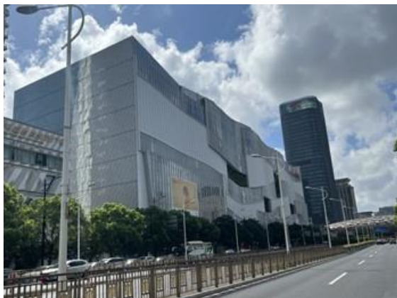
项目外观-西侧
