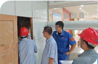
电气安全专项检查
