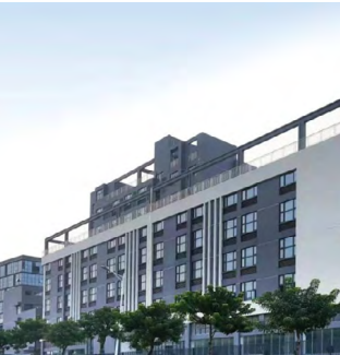
珠海逸科兴基地
