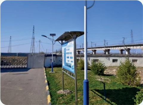
廠區換裝節能照明設施
