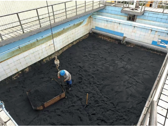
重慶僑立水務公司採用不停產作業方式對濾池濾料和濾頭進行深度清洗
