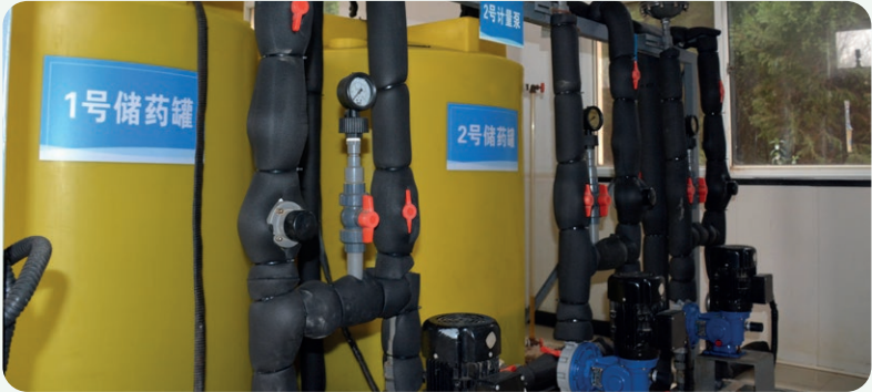
對設備及管道落實防凍保溫措施
