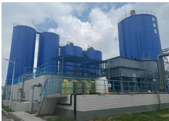
东区新建污水处理系统
