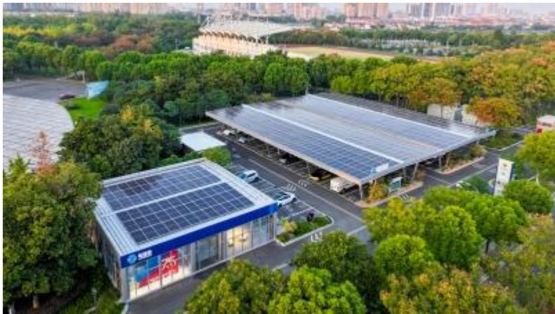
常州金坛体育馆站
