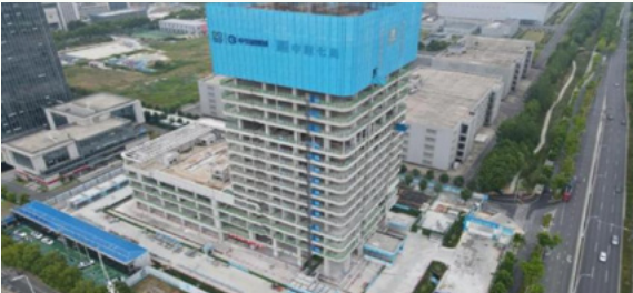
总部研发基地建设项目施工现场图
