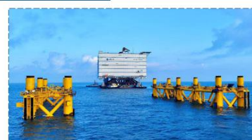
如东海上柔直工程换流站
