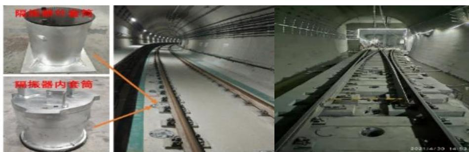
2) 预制式钢弹簧浮置板：区别于现浇浮置减振道床，预制式钢弹簧浮置板在施工现场之外的工厂预先生成混凝土轨道板，整板运抵项目现场后，进行快速铺设，开启了“环保、绿色、高效、低碳”建造高质量、高效率、高性能的隔振轨道工程模式，大幅度提升了轨道工程预制装配化率，
