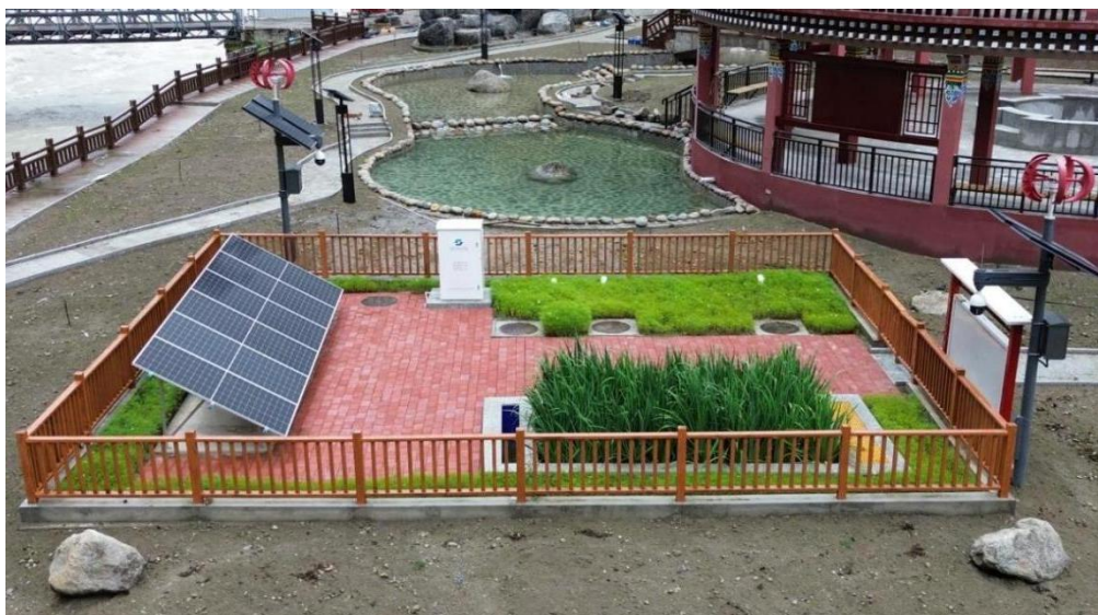
西藏自治区农村污水处理项目
