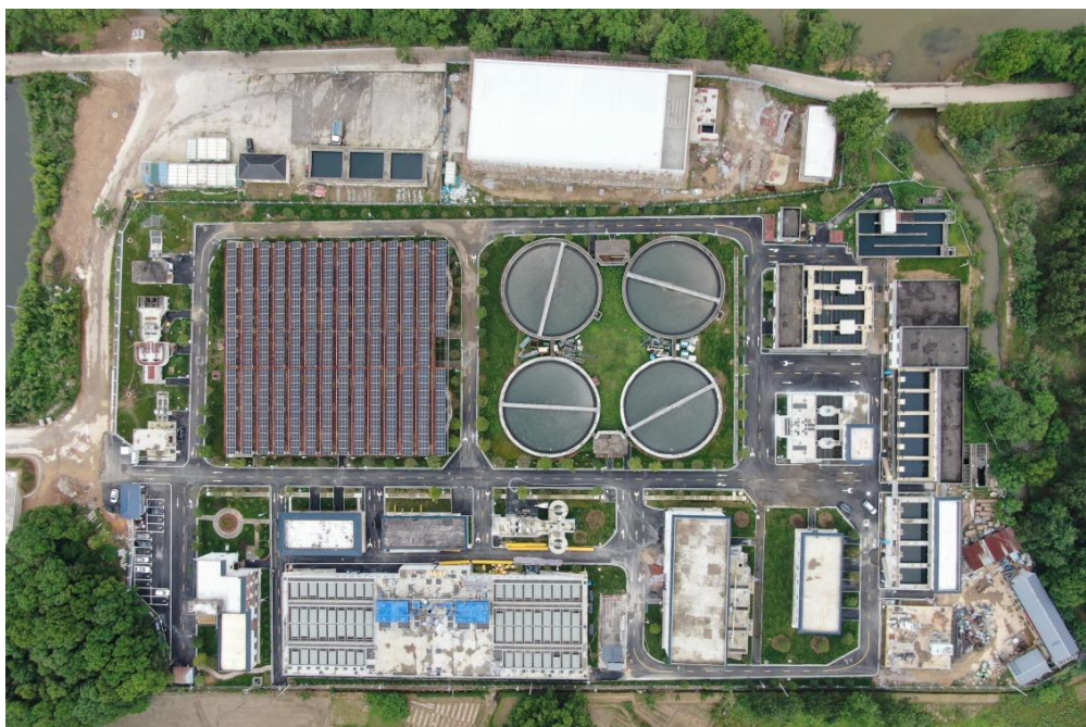
江西省污水处理厂扩建项目
