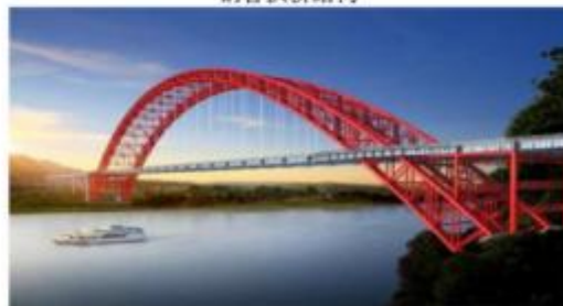
图例：四川犍为岷江特大桥
