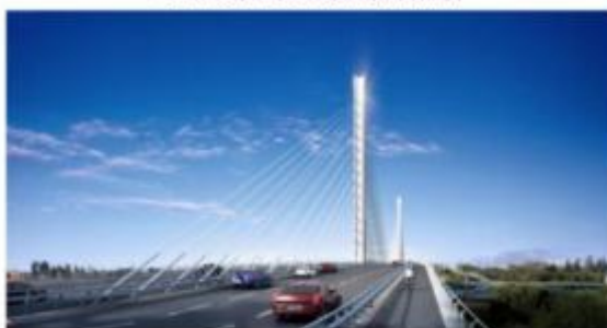
图例：上海泖港大桥
