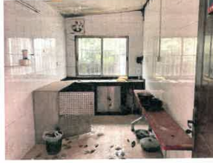
宗地内建筑物
