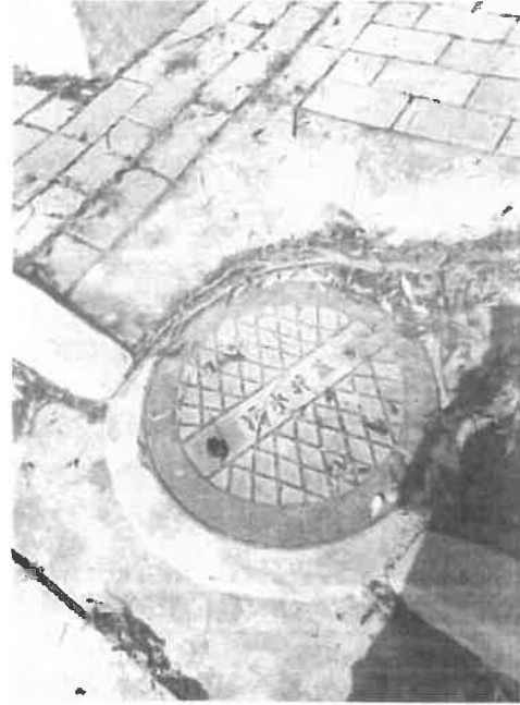
污水井盖-4照片
