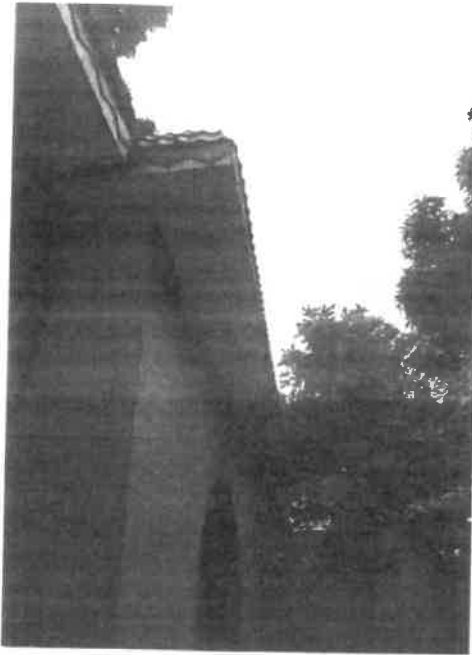
房屋飘板-5照片
