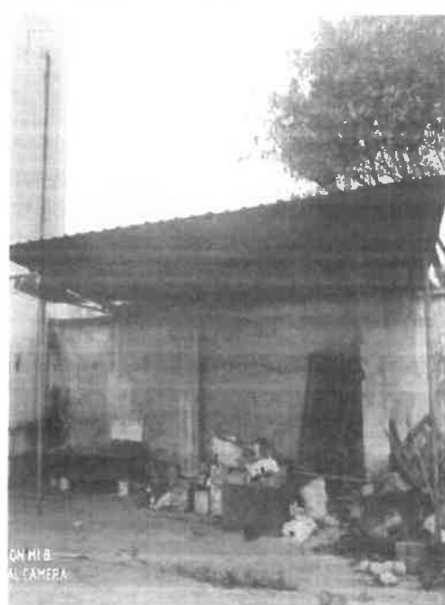
房屋飘板-1照片
