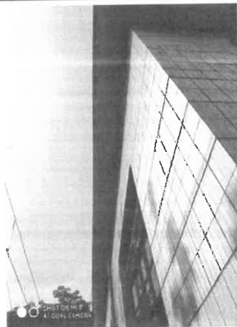
房屋飘板-12照片
