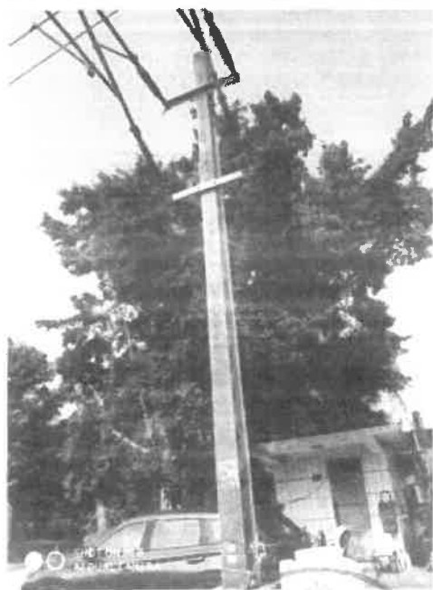
水泥横腹杆-19照片
