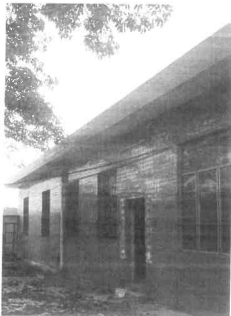
房屋飘板-1照片
