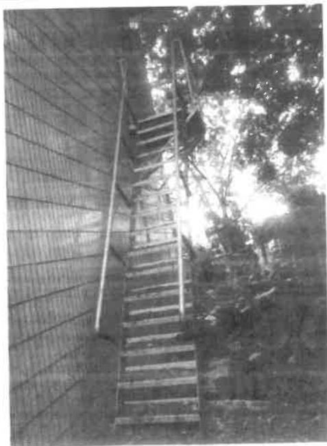
户外逃生通道外墙铁楼梯照片
