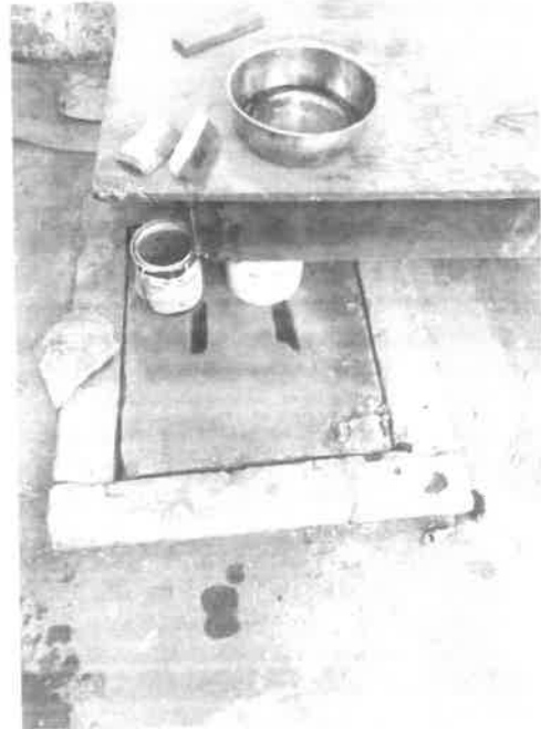
污水井盖-1照片
