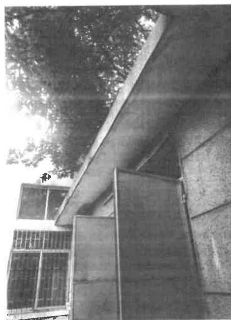
房屋飘板-4照片
