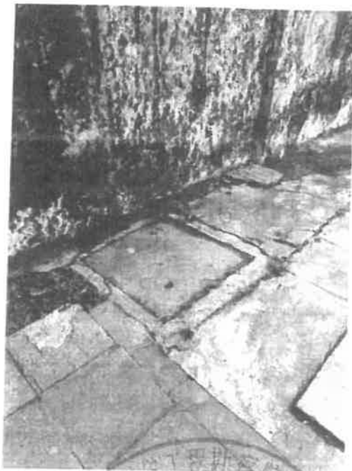
电力井盖-2照片
