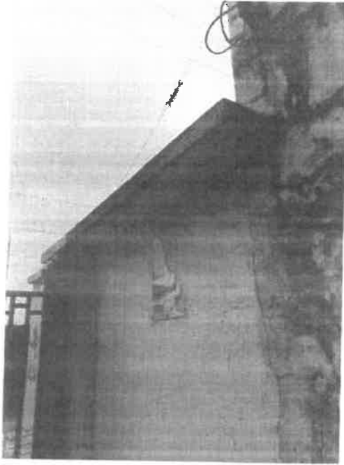
房屋飘板-5照片
