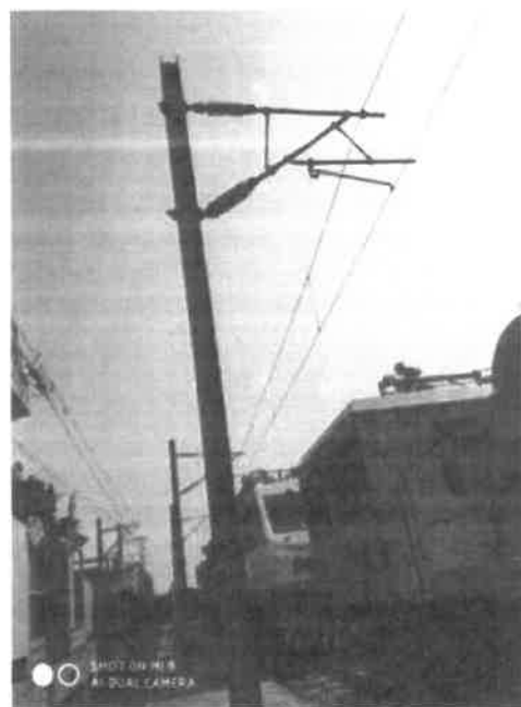
水泥横腹杆-11照片
