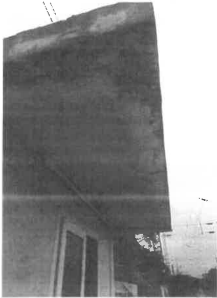
房屋飘板-4照片
