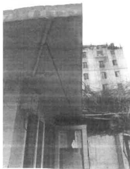
房屋飘板-3照片
