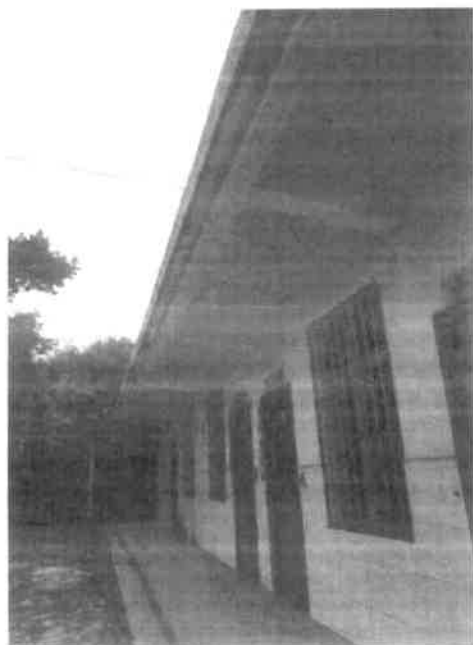
房屋飘板照片
