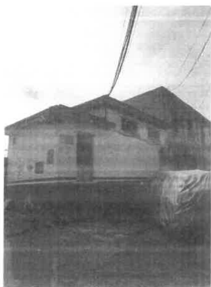
房屋飘板-2照片
