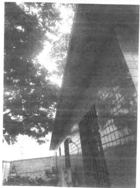
房屋飘板-2照片
