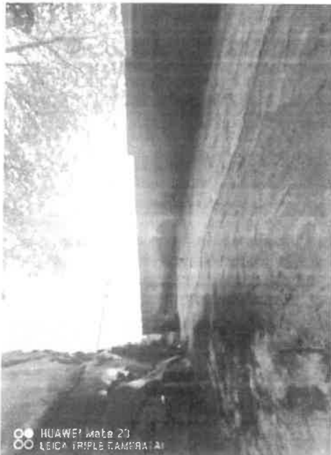
房屋飘板-1照片
