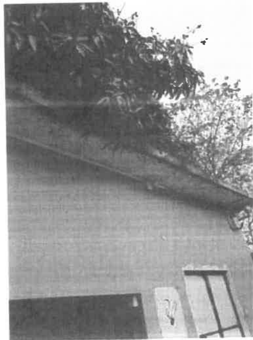
房屋飘板-4照片
