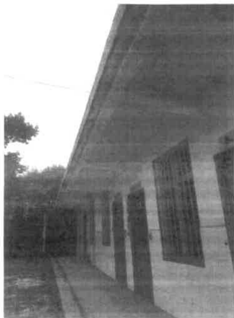
房屋飘板照片
