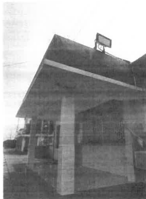
房屋GW08-1门廊(A)照片
