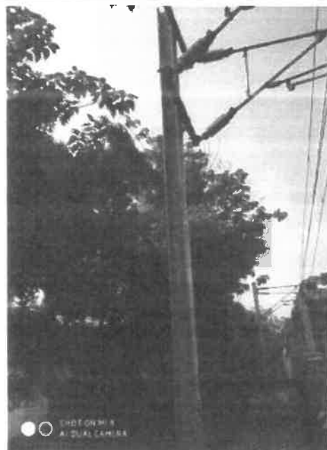
水泥横腹杆-16照片
