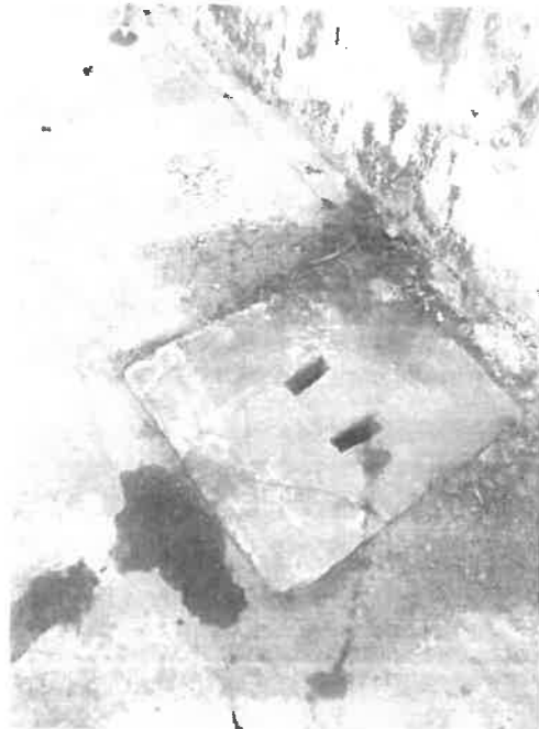
污水井盖-7照片
