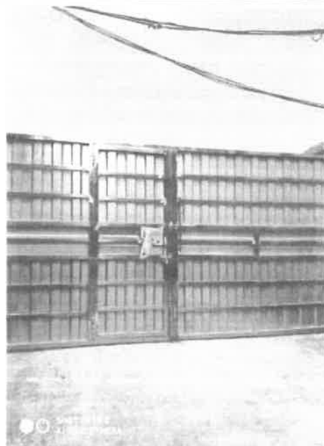
室外独立铁门-2照片
