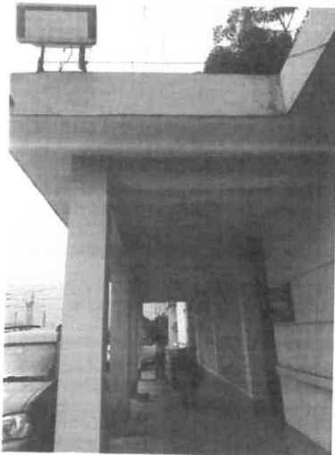
房屋GW08-3门廊(A)照片
