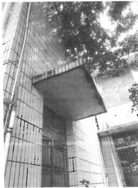
房屋飘板-4照片
