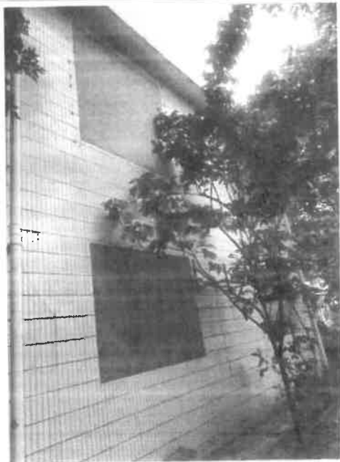
房屋飘板-5照片
