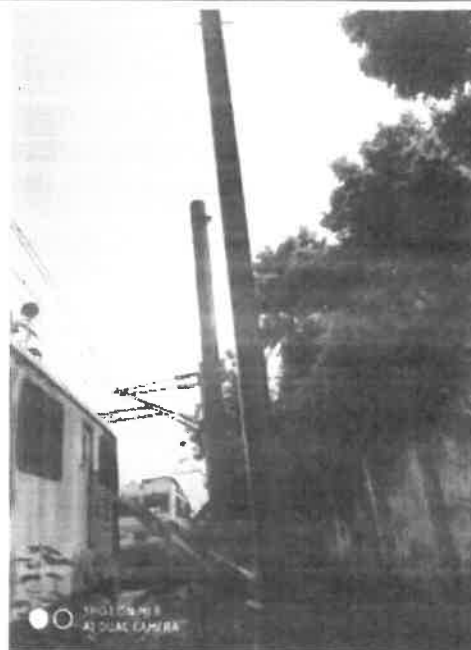
水泥横腹杆-18照片
