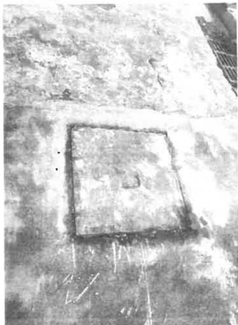
污水井盖-3照片
