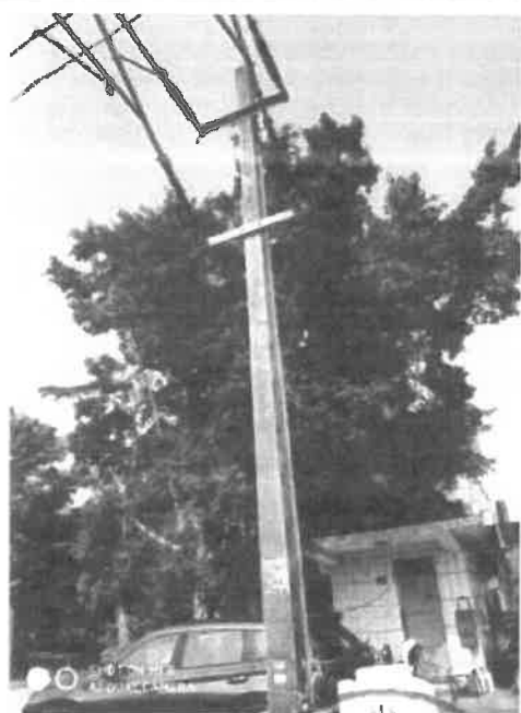
水泥横腹杆-19照片
