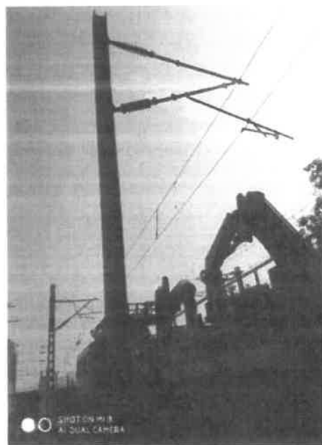
水泥横腹杆-12照片
