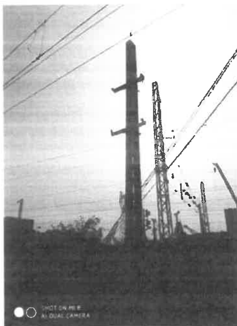
水泥横腹杆-2照片
