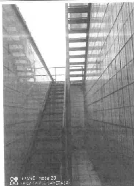
户外逃生通道外墙铁楼梯照片
