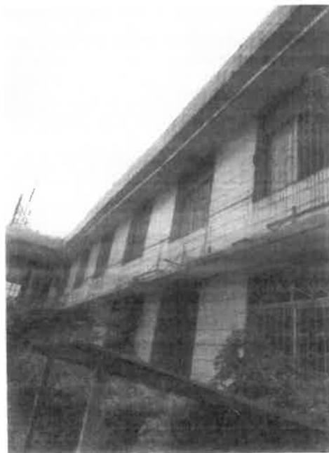
房屋飘板-6照片
