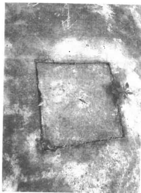
污水井盖-2照片
