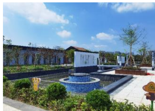
南昌市新建城地下生态水厂（2 万吨/天）
