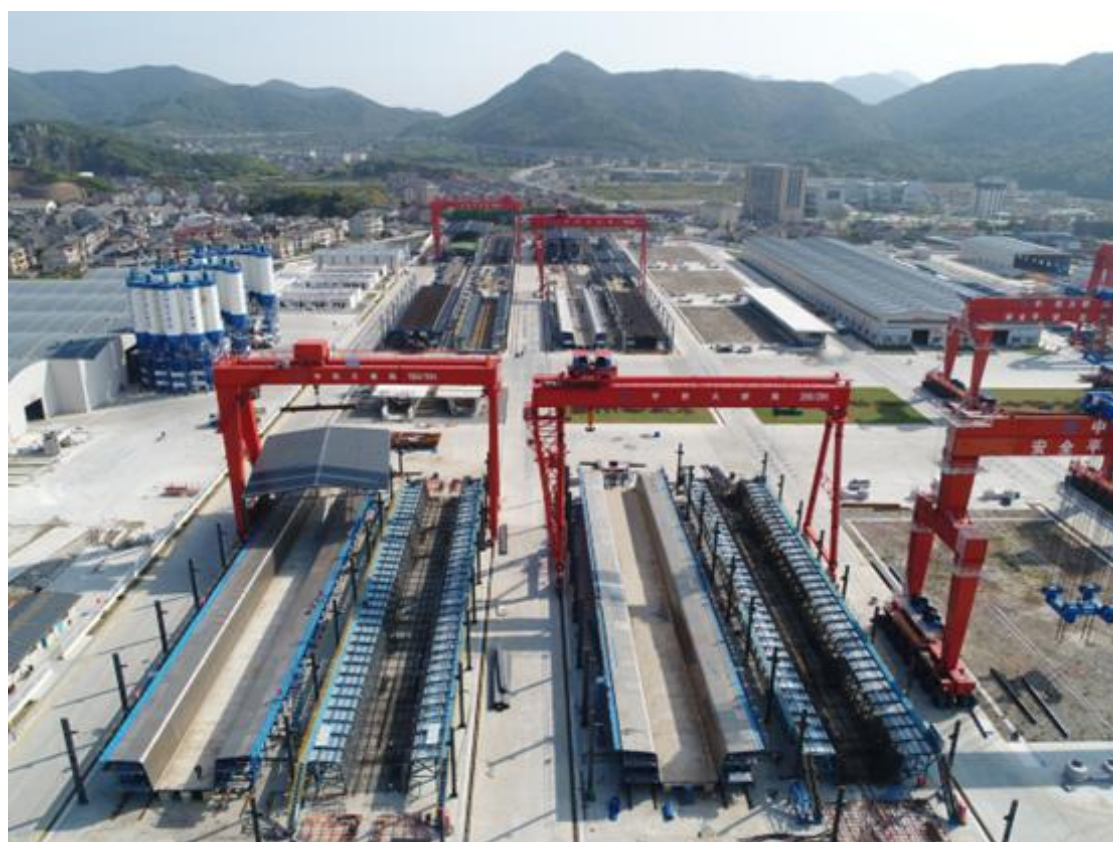
图：整孔梁预制场施工实景
