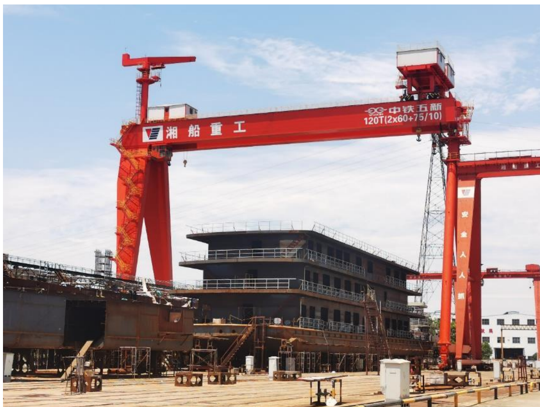
图：造船门式起重机施工实景
