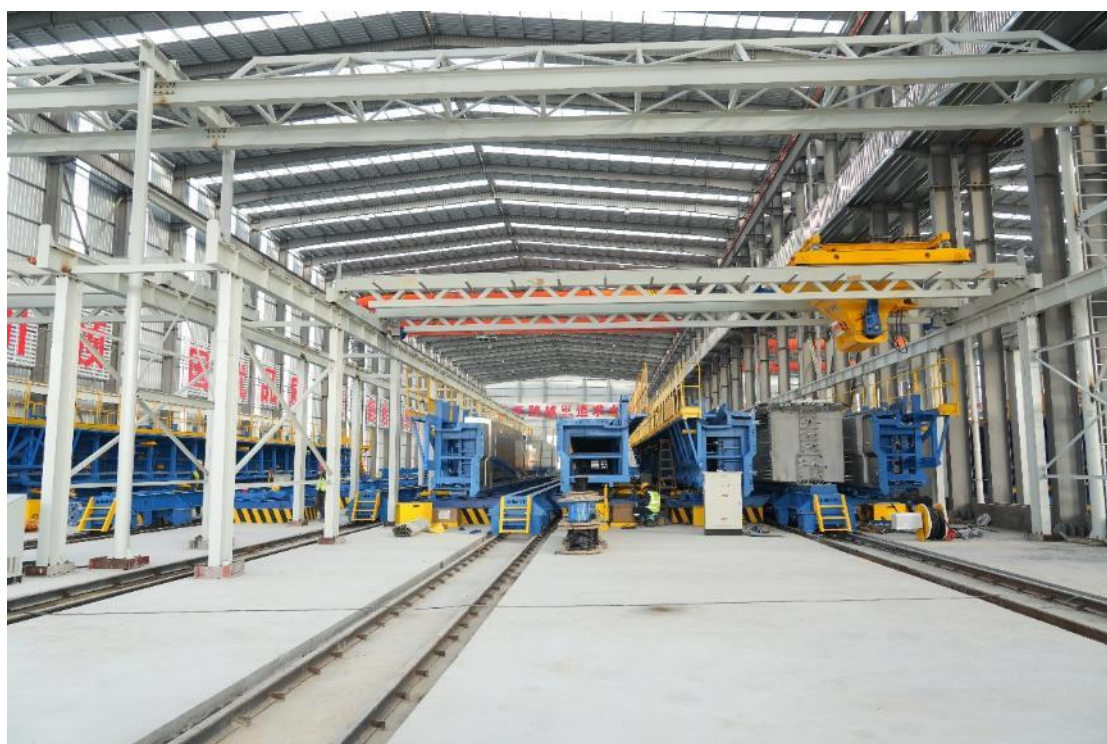
图：T 梁预制场施工实景
