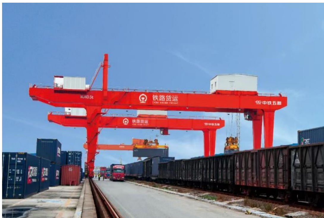
图：铁路货场门式起重机施工实景
