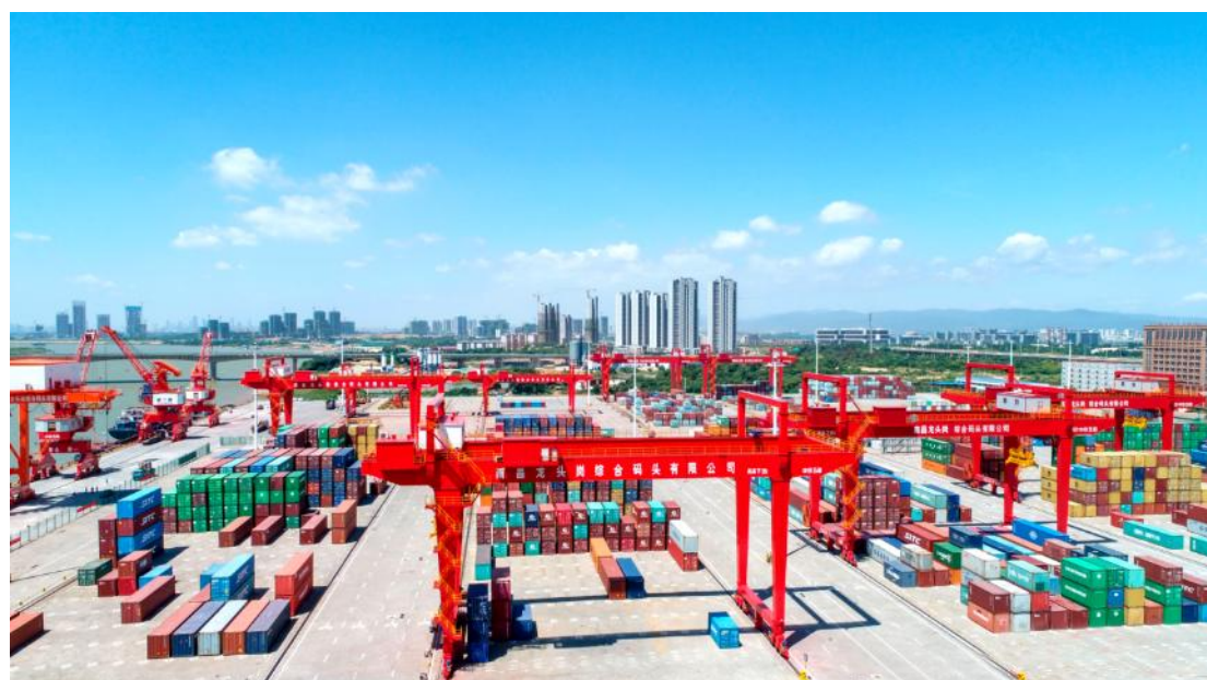
图：轨道式集装箱起重机施工实景
