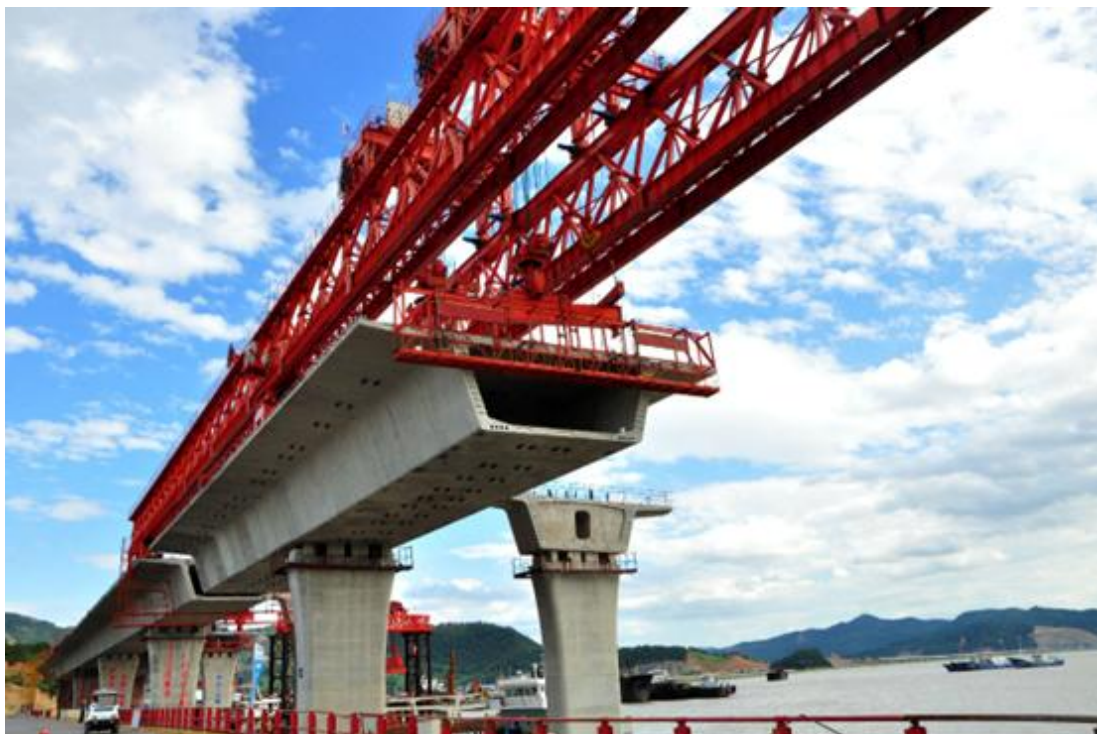
图：节段梁架设实景
