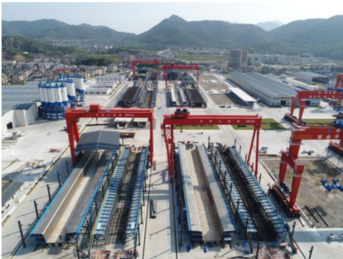
图：整孔梁预制场施工实景
