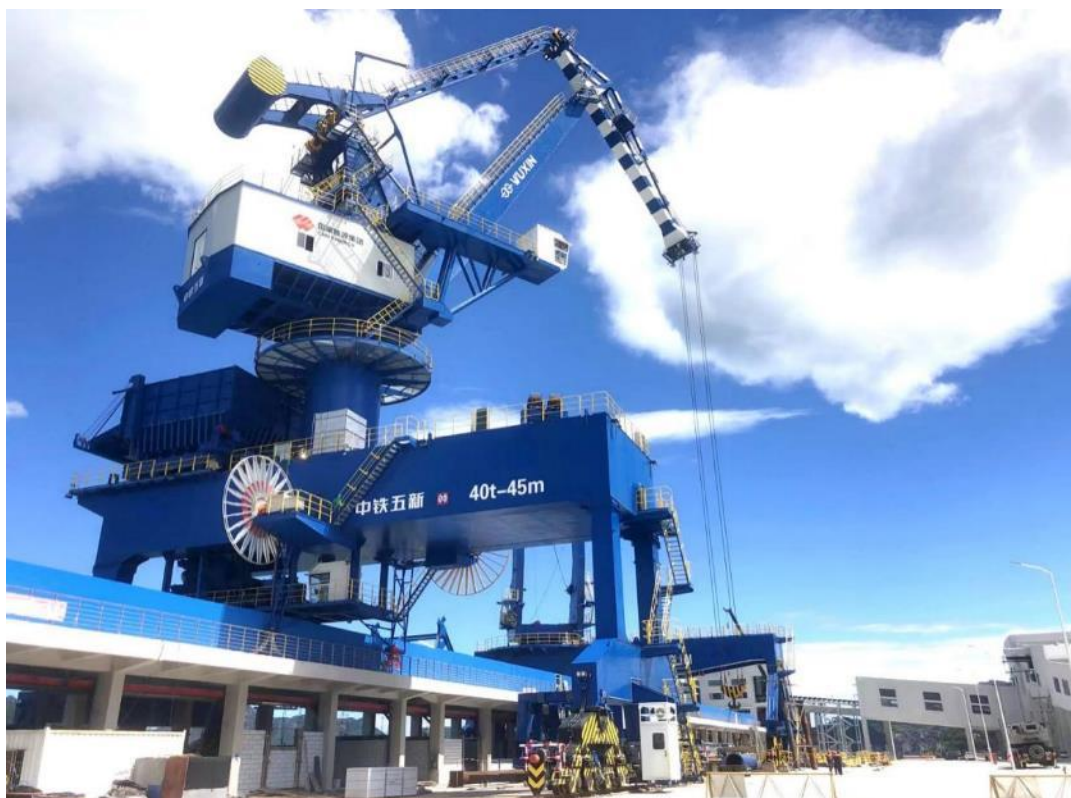
图：带斗门座起重机施工实景
