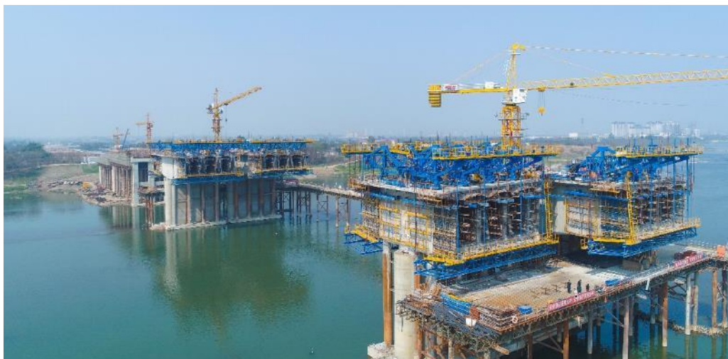
图：挂篮施工实景
