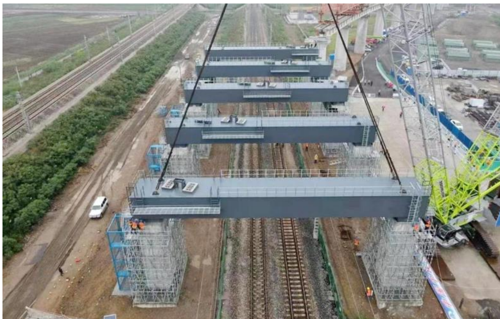
图：门式墩钢梁施工实景
