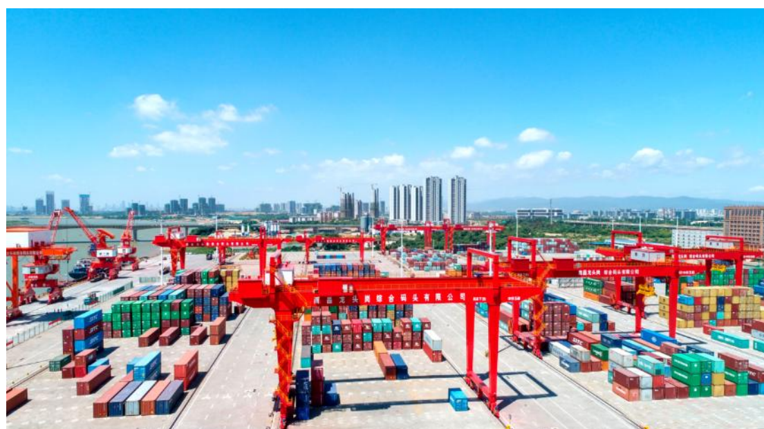
图：轨道式集装箱起重机施工实景
