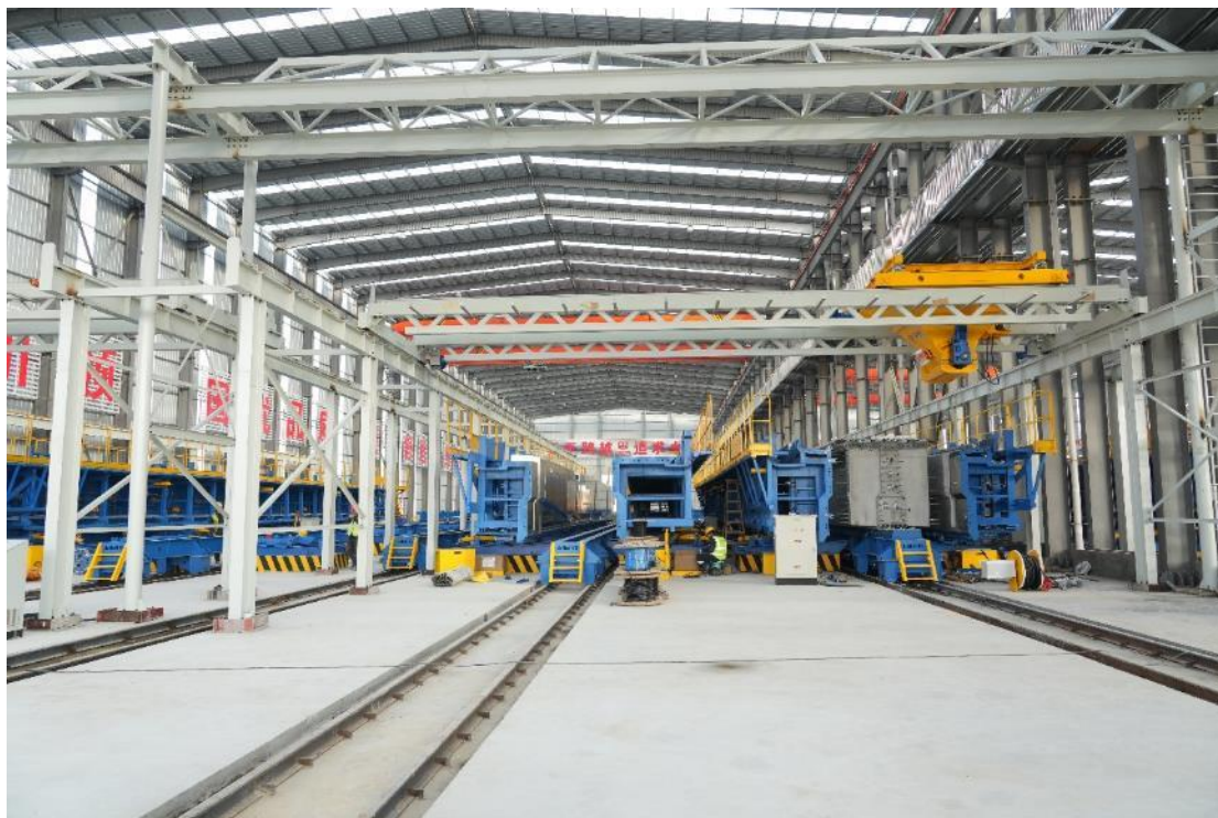
图：T 梁预制场施工实景
