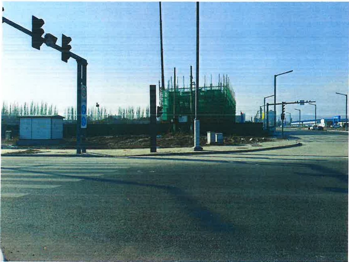
案例 B 实地勘察照片
