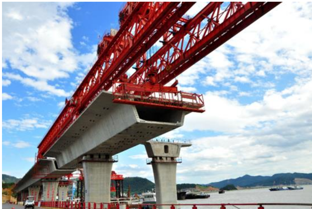
图：节段梁架设实景
