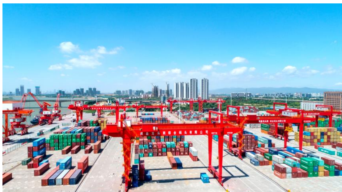
图：轨道式集装箱起重机施工实景
