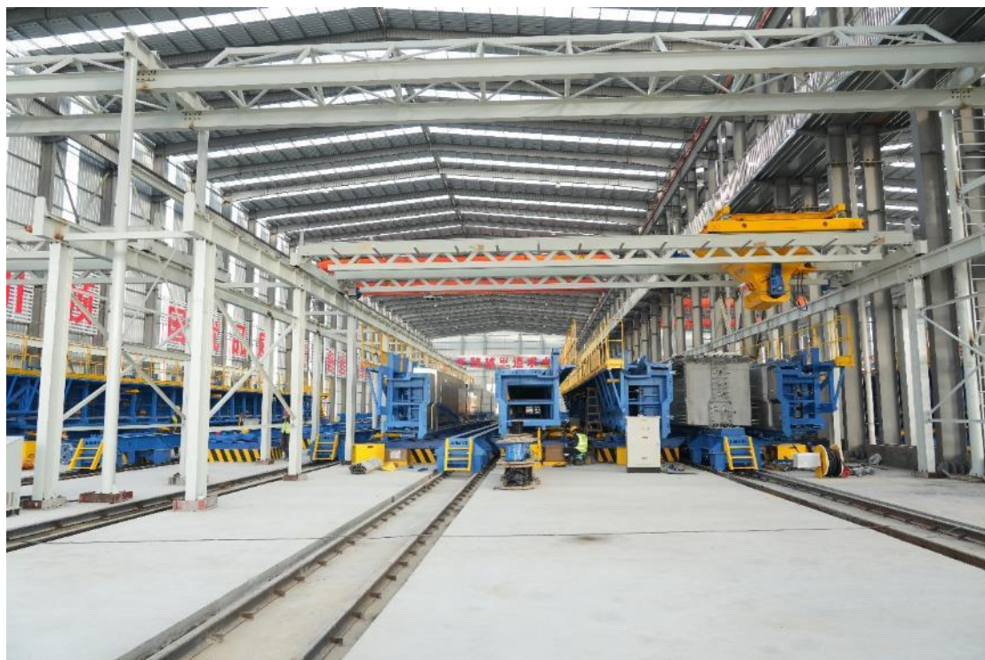
图：T 梁预制场施工实景
