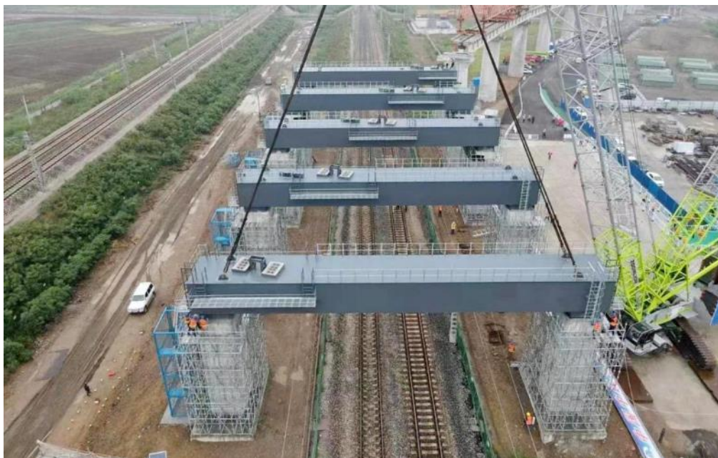
图：门式墩钢梁施工实景
