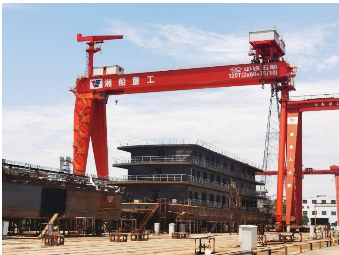
图：造船门式起重机施工实景
