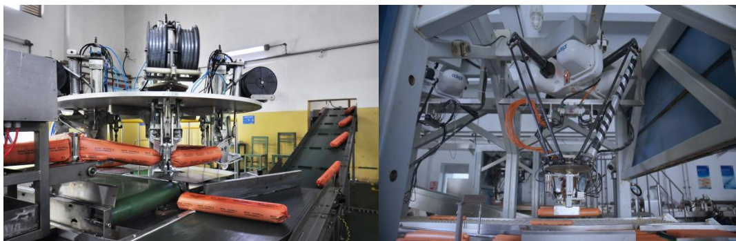
图六 乳化炸药生产线
