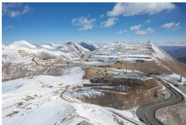
图五 西藏巨龙铜矿混装项目
