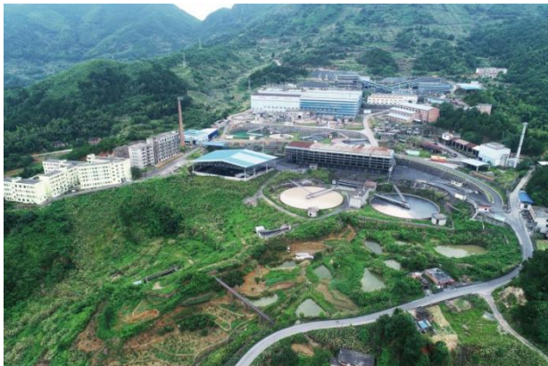
图三 衡阳采选一体化项目
