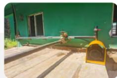
秭归环保公司除臭楼循环水泵改造项目：在除臭楼靠山一侧重新布设管道并加装一台循环水泵，将水泵安装在空旷、便于巡检维护的区域，有效降低了水泵故障率，同时大幅减少了作业人员的劳动强度及在有毒有害环境中的暴露时间，切实保障职工职业健康。
