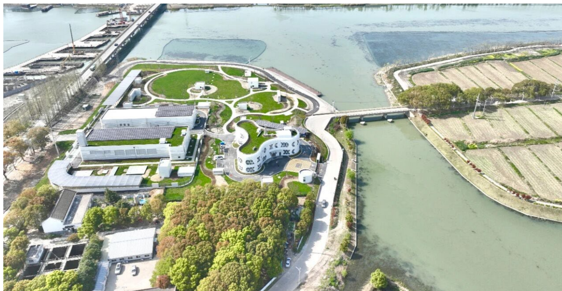
▶ 西岑污水處理廠項目
