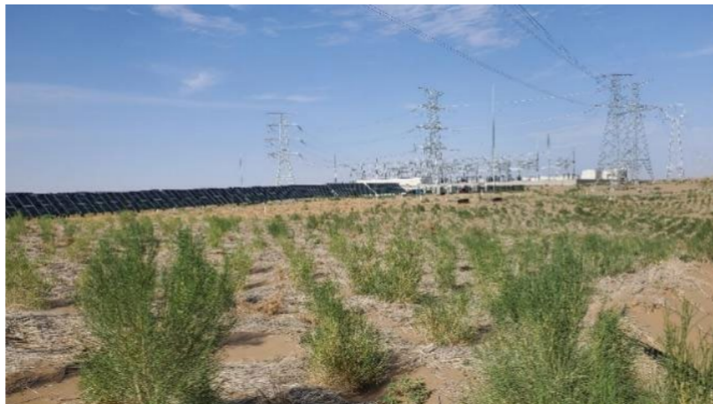
九墩滩光伏治沙项目现场图
