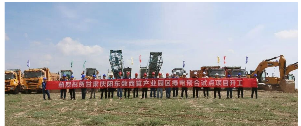
“东数西算”产业园区绿电聚合试点项目开工
