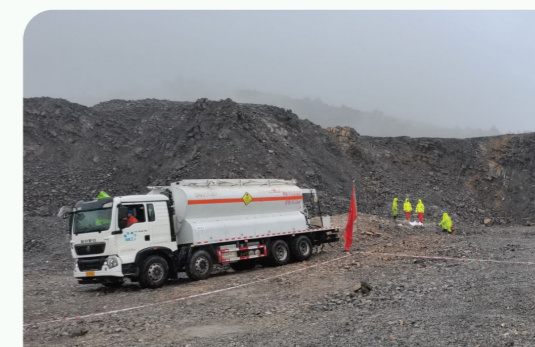
混装水胶炸药爆破施工
