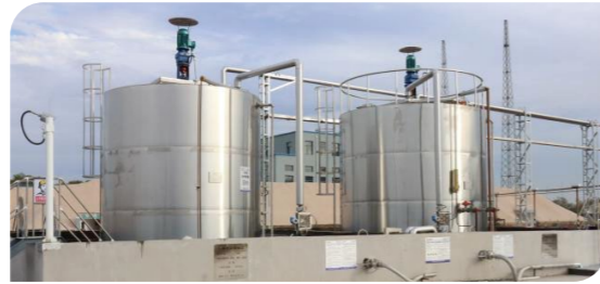
乳化炸药生产线智能化技术改造项目
