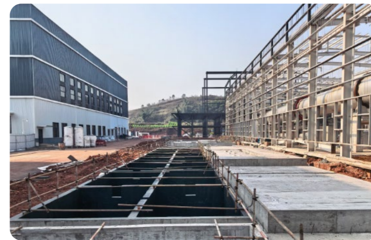
四川基地废水处理设备设施建设现场
