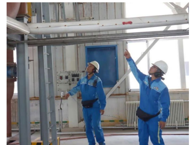
▲ 隐患排查现场
