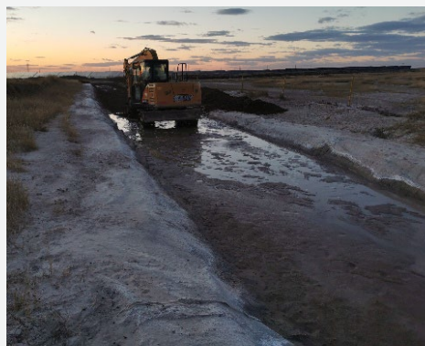
电站排洪治理工程
