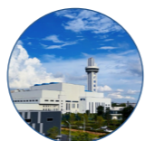
福山循环经济产业园 (广州市第三资源热力电厂)
