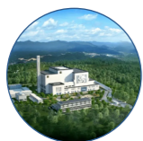
邵东市生活垃圾焚烧发电项目 (控股 50%)
