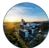
从化循环经济产业园 (广州市第七资源热力电厂)
