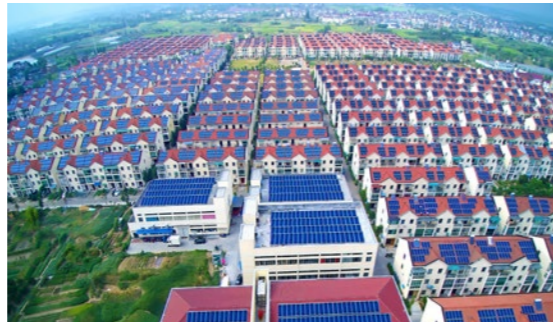
正泰安能分布式光伏电站项目
