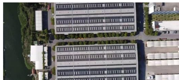
广日股份昆山工业园光伏屋顶
