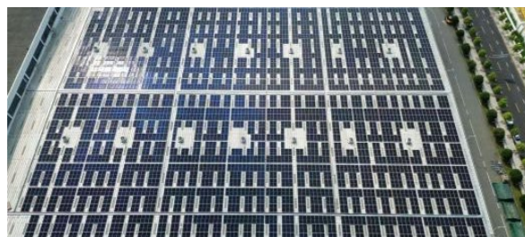
广日股份成都工业园光伏屋顶
