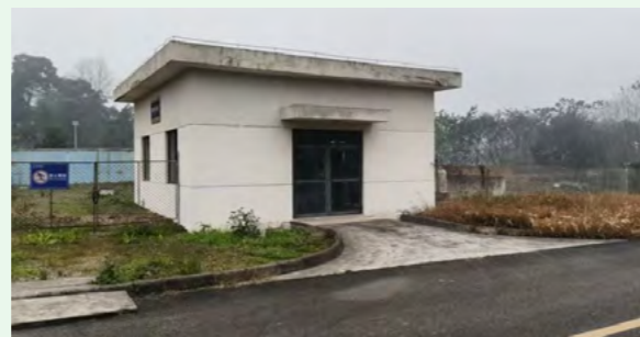
航天能源污水处理站
