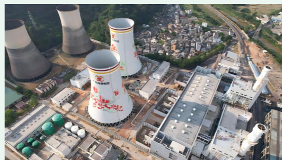
云浮天然气热电联产项目现场
