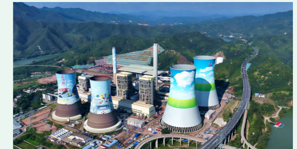
广东粤电大埔电厂二期工程现场
