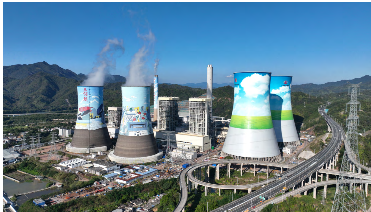
大埔电厂二期工程项目实现双机投产
