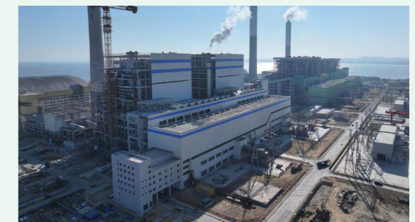
惠来电厂 5、6 号机组扩建项目（2×1000MW）工程现场
