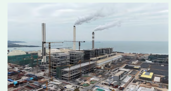
汕尾电厂 5、6 号机组扩建项目（2×1000MW）工程现场
