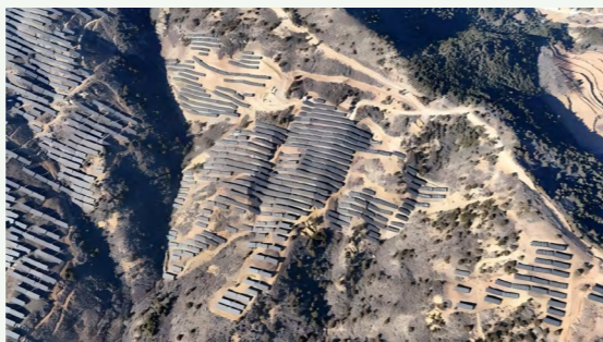
广东粤电泽州 170MW 光伏发电项目光伏区
