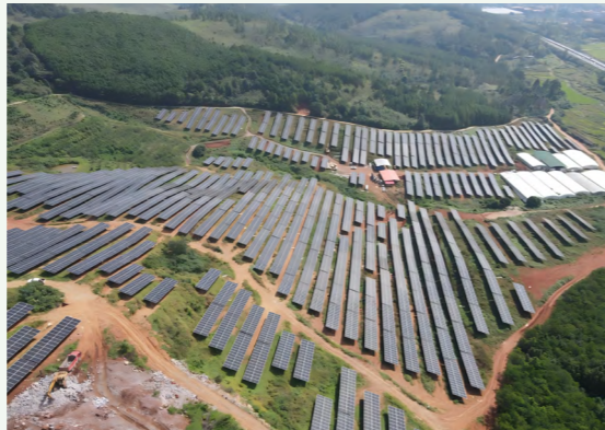
蓝山楠市农光互补 200MW 光伏发电项目光伏区
