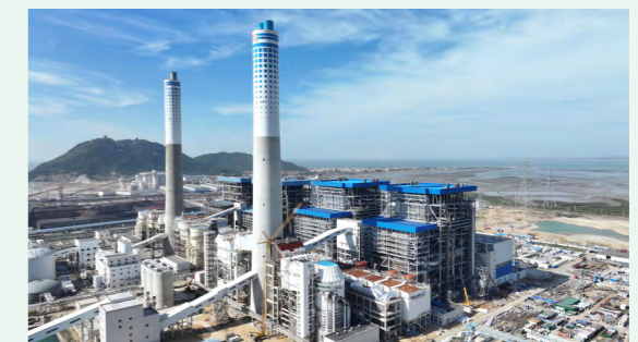
茂名博贺电厂 3、4 号 2×1000MW 机组工程现场
