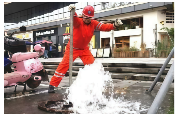
开展消防栓巡检
