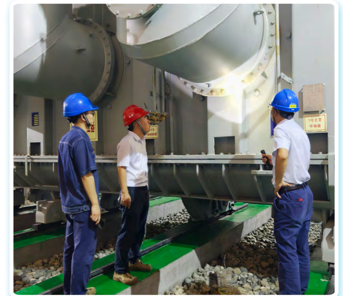
强化作业过程监管
