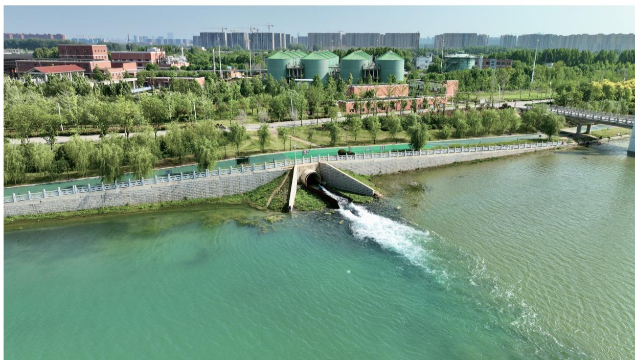
马头岗水务分公司出水汇入贾鲁河
